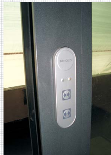
Upravljanje tiptronic alumijskom kliznom stijenom
