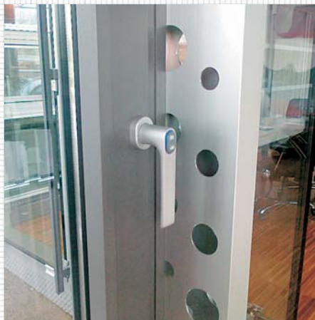
Aluminijski prozor sa tiptronic okovom
