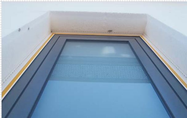
Toplinska provodljivost aluminijskog prozora: od 0,9 do 2,1 W/m 2 K
