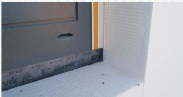
Donji detalj prije ugradnje klupčice
