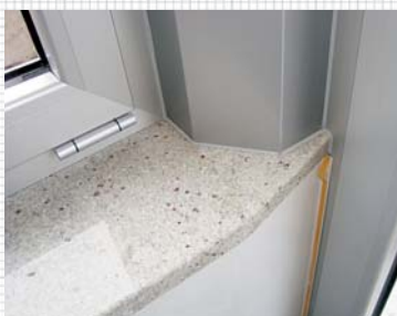
Detalj spoja aluminijskog prozora sa kamenom klupčicom
